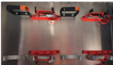
Bildet viser oppheng for 2 stk. røykdykkerapparat og 2 stk. reserveflasker.
